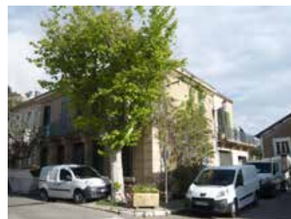
Renforcement de la charpente pour créer un étage intermédiaire
