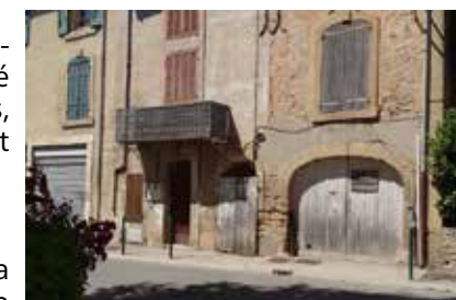
Projet de rénovation des immeubles des numéros 13 et 15 rue Mère de Dieu à Peyrolles
